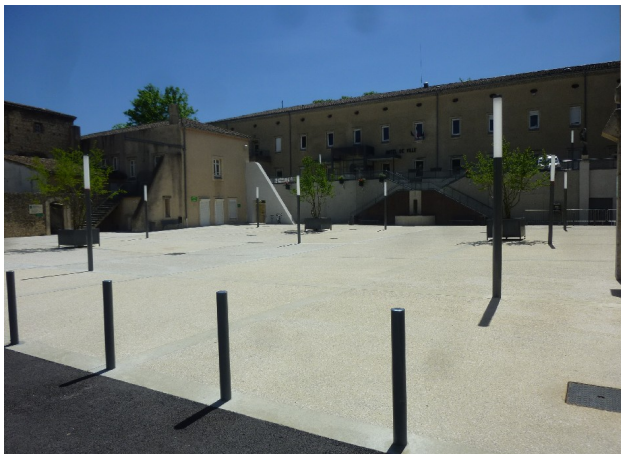
Photo des travaux terminés
